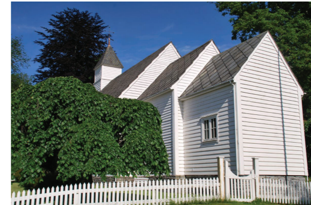
Fjelberg prestegard foto Kvinnherad kommune
