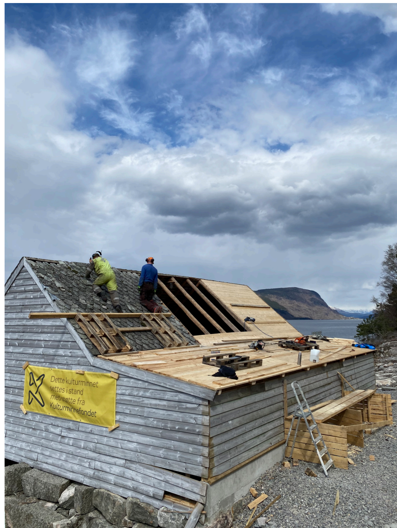
Restaurering av båtbyggerverkstaden på Ramsgrø gd. Foto Hilde Solli
